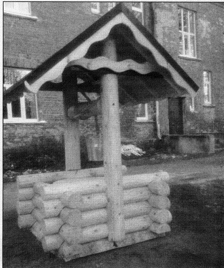
● Silajāniešu realizētais projekts – aizvietots novecojušais akas augšējais grods ar koka guļbūvi.
