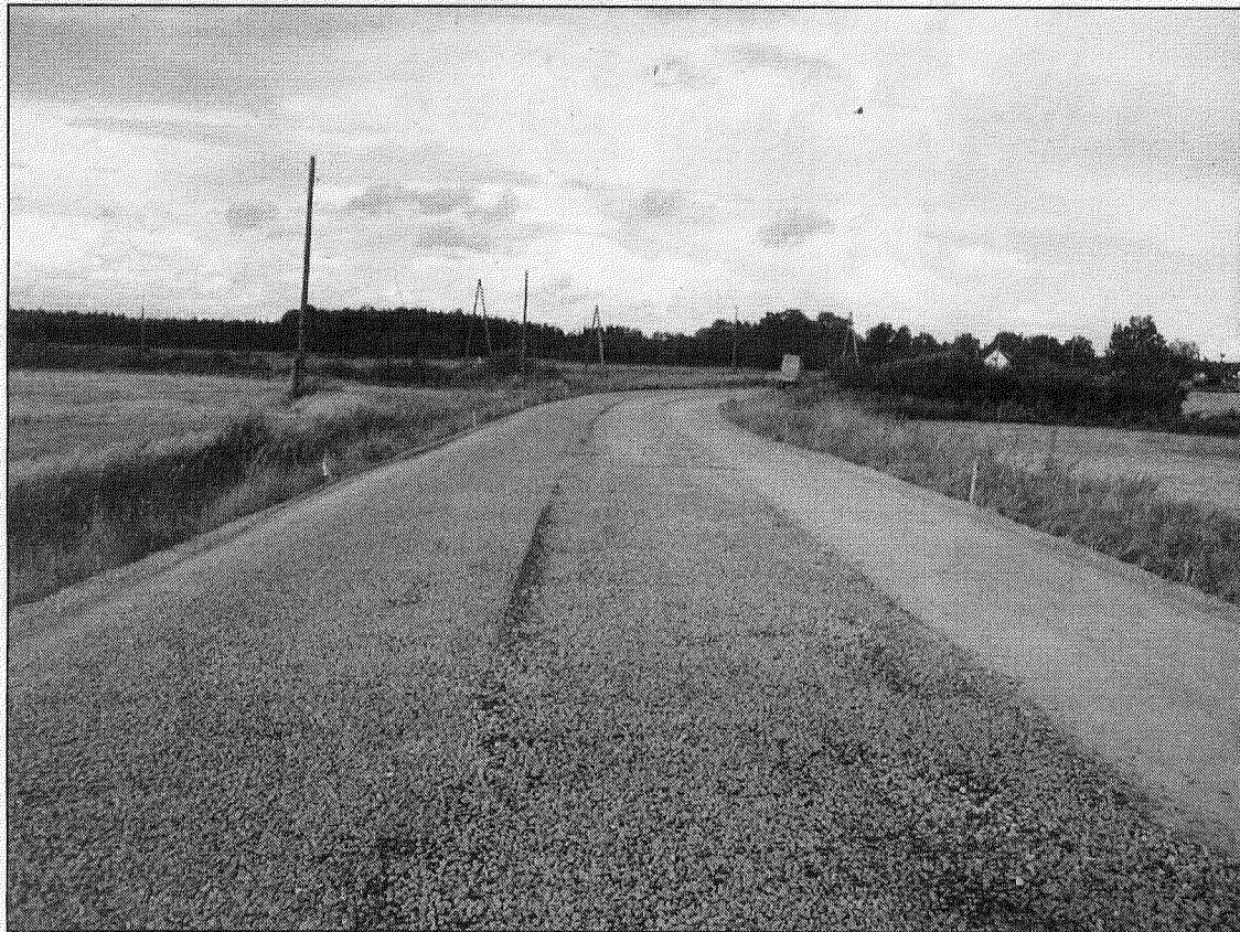
● Jaunās tehnoloģijas izbūve uz grants ceļiem – tiek pielīmētas divas šķembiņu kārtas ar bitumena emulsiju.
