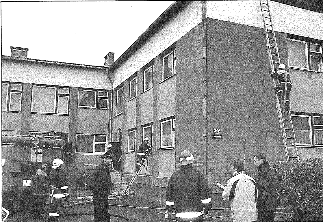
● Lai pārbaudītu, vai liesmas nav skārušas bēniņus, ātri tiek uzslietas saliekamās kāpnes. Ugunsdzēsēji var ziņot – viss kārtībā.
